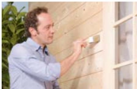
Die abgeschliffene oder neue Holzoberfläche wird mit Consolan Holzgrund grundiert.
